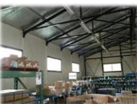
倉庫の屋根裏
