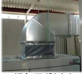
排気用ダクトを接続して、断熱する
